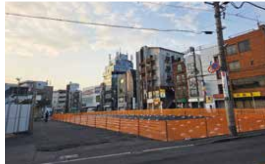
▲薬師駅前協同ビル解体後の状況
