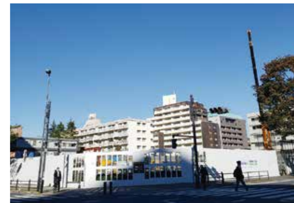
▲現在、建設中の区役所新庁舎
