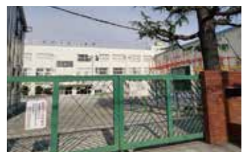
▲旧上高田小学校(現令和小学校)
