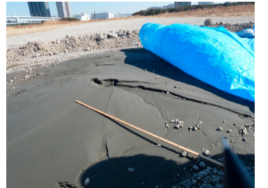
▲東日本大震災の時には、豊洲新市場予定地の敷地内で液状化により108箇所噴砂、噴水が発生しました。液状化で汚染が新たに地中に広がった恐れもあります。
