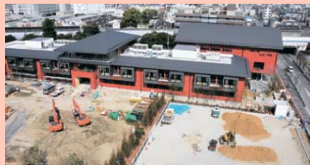
▲「森友疑惑」隠しも許しません(写真は森友学園の小学校の建設現場)
